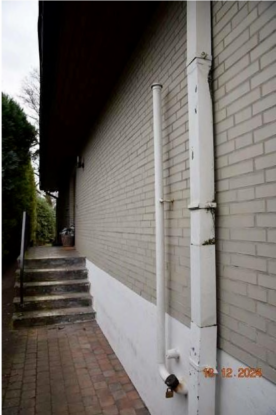
Foto Nr. 1/18 – Übersichtsfoto linke Gebäudeseite – fotografiert von vorne nach hinten
