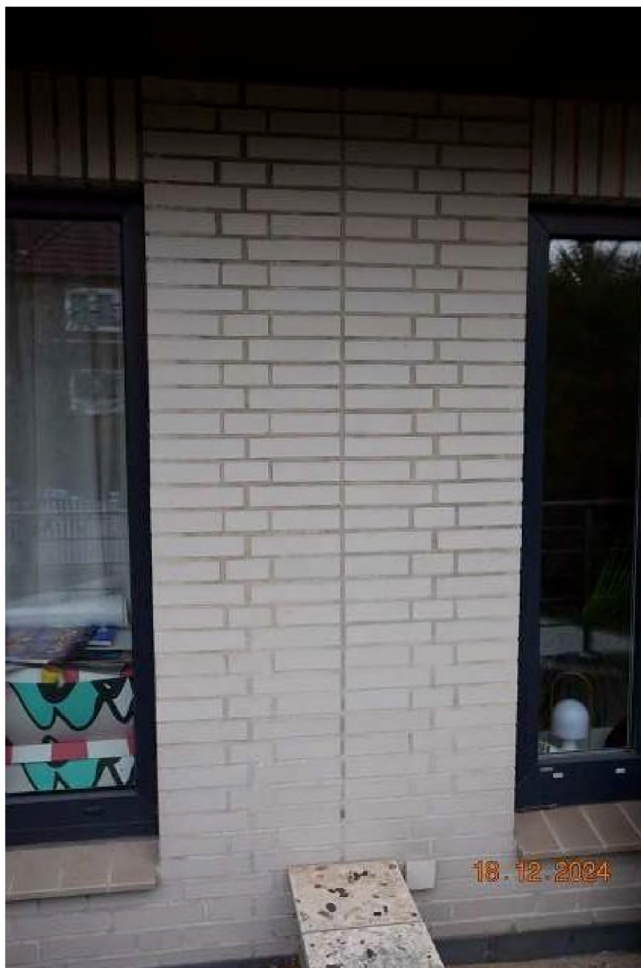
Foto Nr. 1/17 – Übersichtsfoto Gebäudetrennfuge
