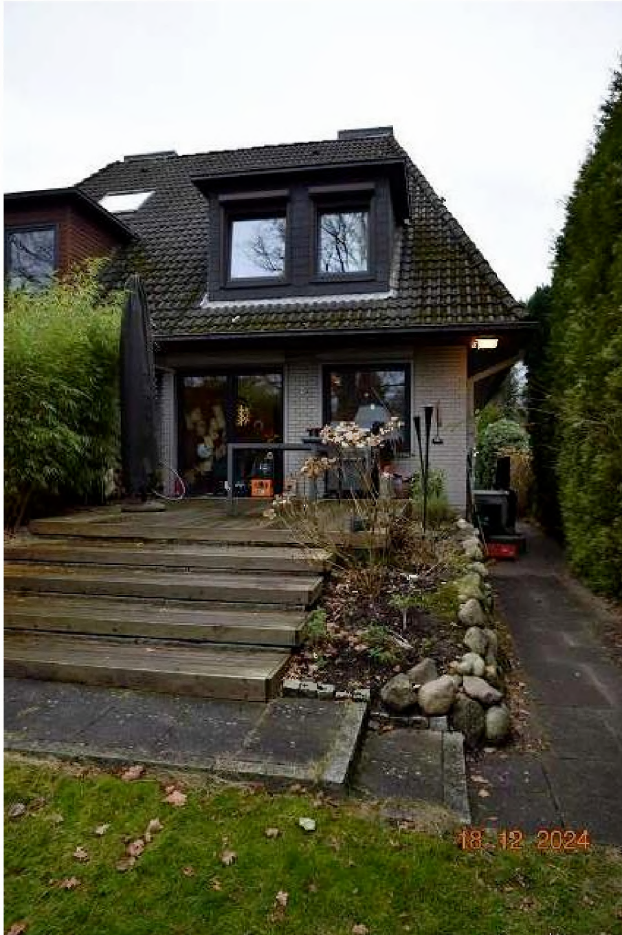
Foto Nr. 1/24 – Übersichtsfoto Gebäuderückseite
