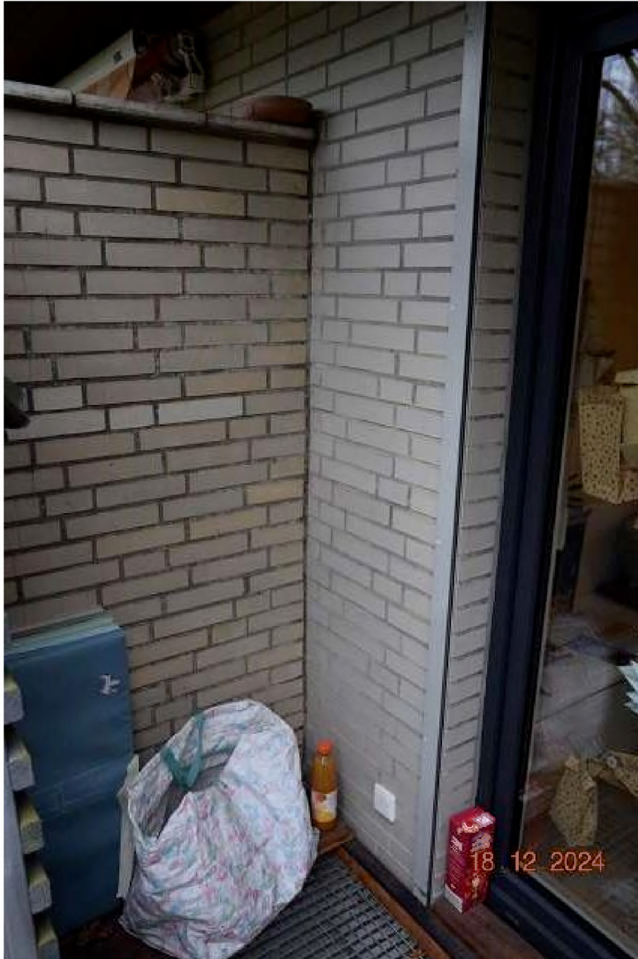
Foto Nr. 1/27 – Übersichtsfoto Sichtschutzwand zum Nachbargebäude
