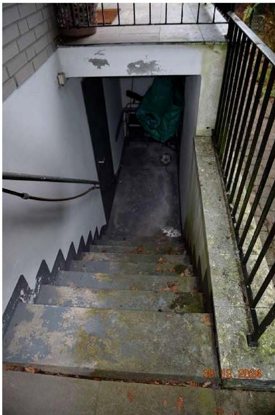
Foto Nr. 1/22 – Übersichtsfoto abgehende Kelleraußentreppe
