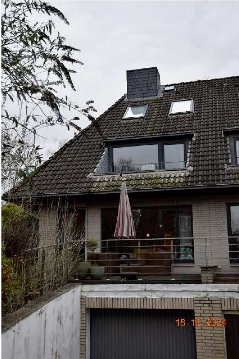
Foto Nr. 1/12 – Übersichtsfoto Fassade Straßenseite
