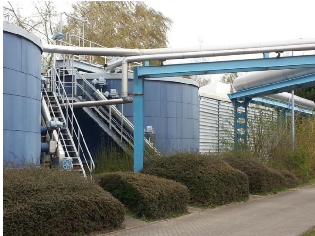
Koagulation und 2. biologische Behandlungsstufe (Nitrifikation)
