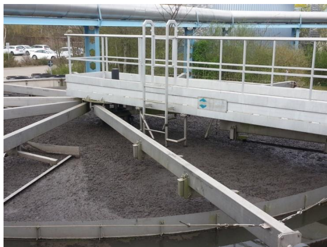
Schlamm-Eindickung (Entwässerung)
